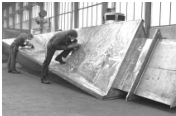
Bau der Säule bei der Firma Pondorf in Kassel.
